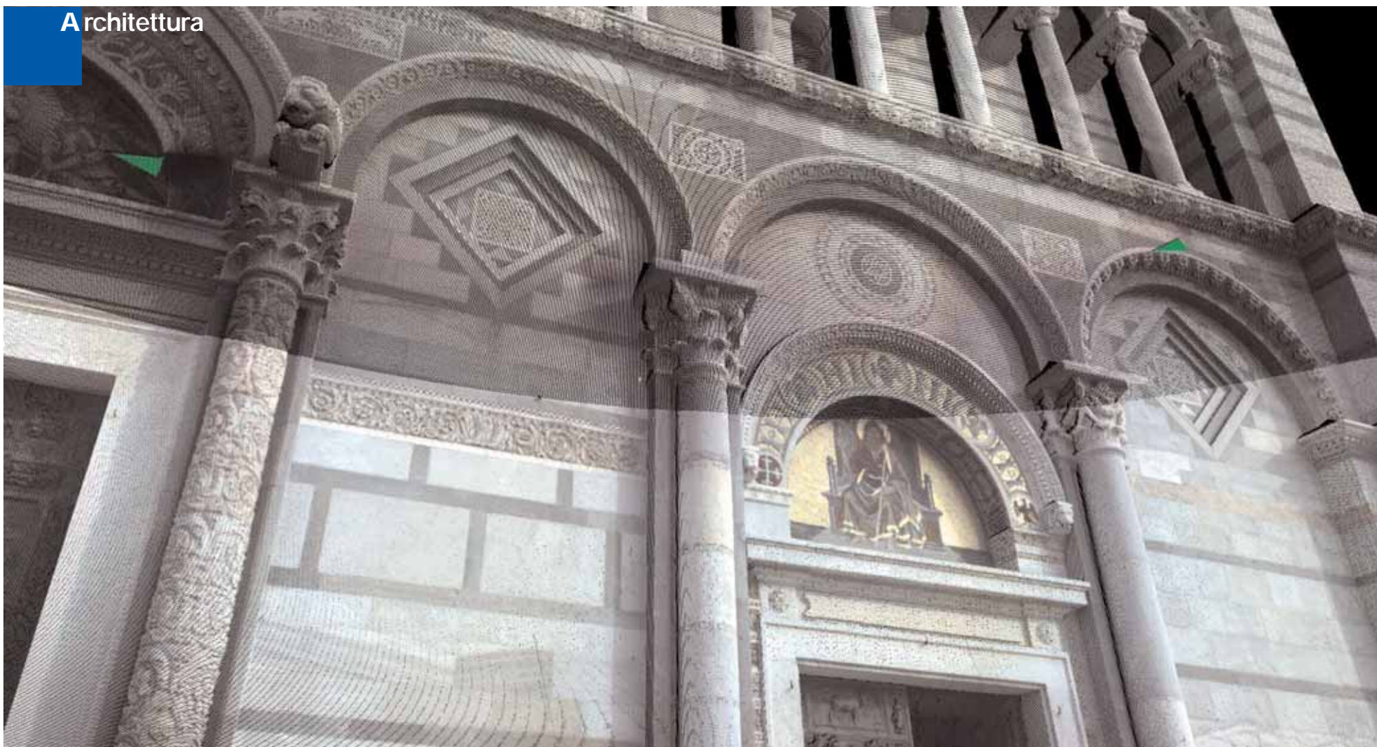
Vista di una singola scansione con l'acquisizione automatica della texture da parte del Leica HDS 3000
