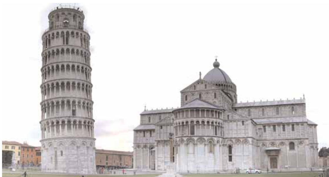
Il rilievo del paramento esterno del Duomo è stato eseguito in pochi giorni dal DIAPReM di Ferrara con il supporto del Dipartimento di Progettazione dell'Architettura di Firenze. Sono state applicate procedure integrate topografiche e laser scanner 3D (11 stazioni per circa 88.800.000 punti con il Leica HDS 2500 e 11 stazioni per circa 115.200.000 punti realizzati con il Leica HDS 3000). L'acquisizione è avvenuta definendo una densità di maglia di circa 1 cm con infittimenti su particolari decorativi o strutturali della facciata e dell'abside con maglia di dettaglio di circa 6 mm. È stata realizzata: una scansione di tutto il monumento dai vari punti di osservazione compreso i punti accessibili dall'alto; un'ottimizzazione tramite rilievo topografico realizzato con stazione totale integrata Reflectorless Leica TCR1101 XR; una registrazione di tutte le scansioni con georeferenziazione.
